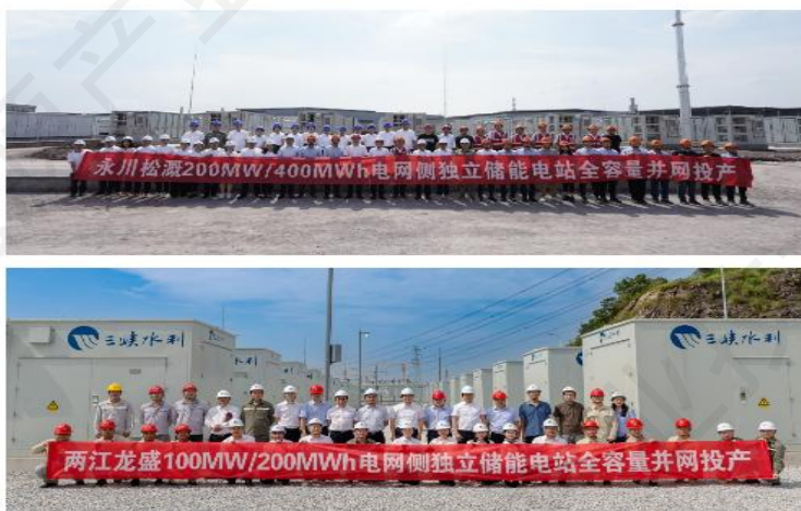
图 8.6 三峡水利总规模 300MW/600MWh 电网侧共享储能电站图
