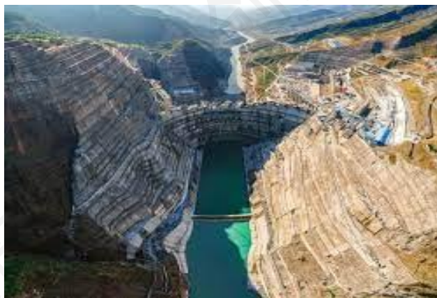
图 1.3 世界在建最大水电站白鹤滩水电站
